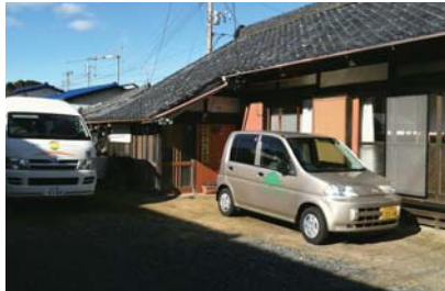
古民家を改修した福祉施設
