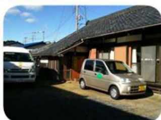
古民家を改修した福祉施設
